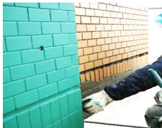
エキスパンションジョイント 打ち継ぎ目地への塗布
