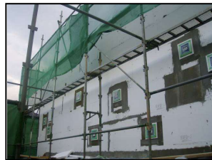
断熱材を張り付け
