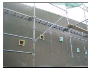
ベースコートの施工
