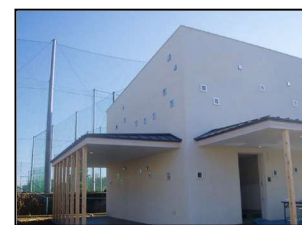
仕上げ材の施工
