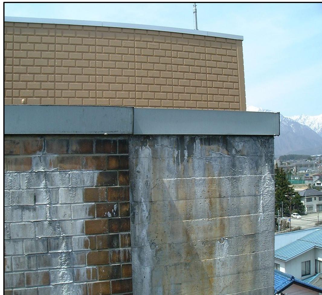
レンガの亀裂、亀裂箇所からの漏水による白華
