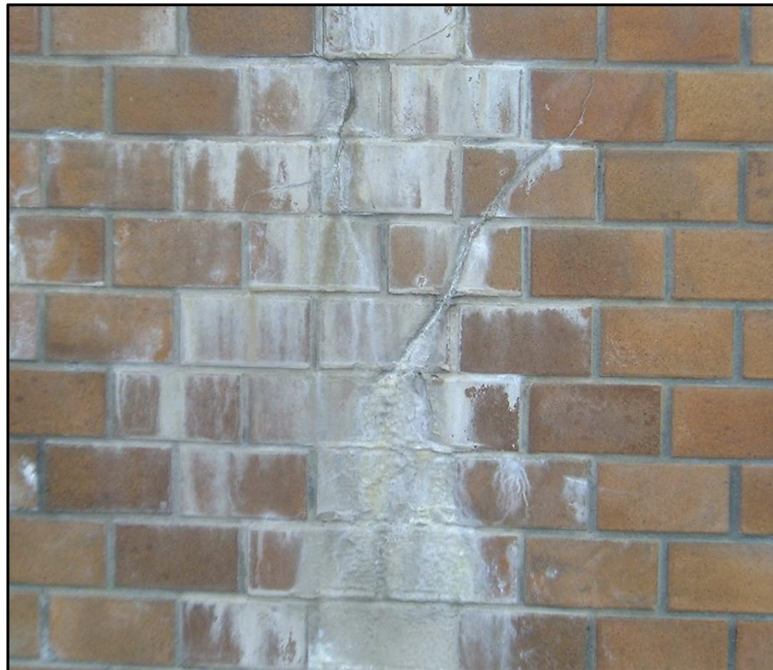
テラスの亀裂と漏水劣化
