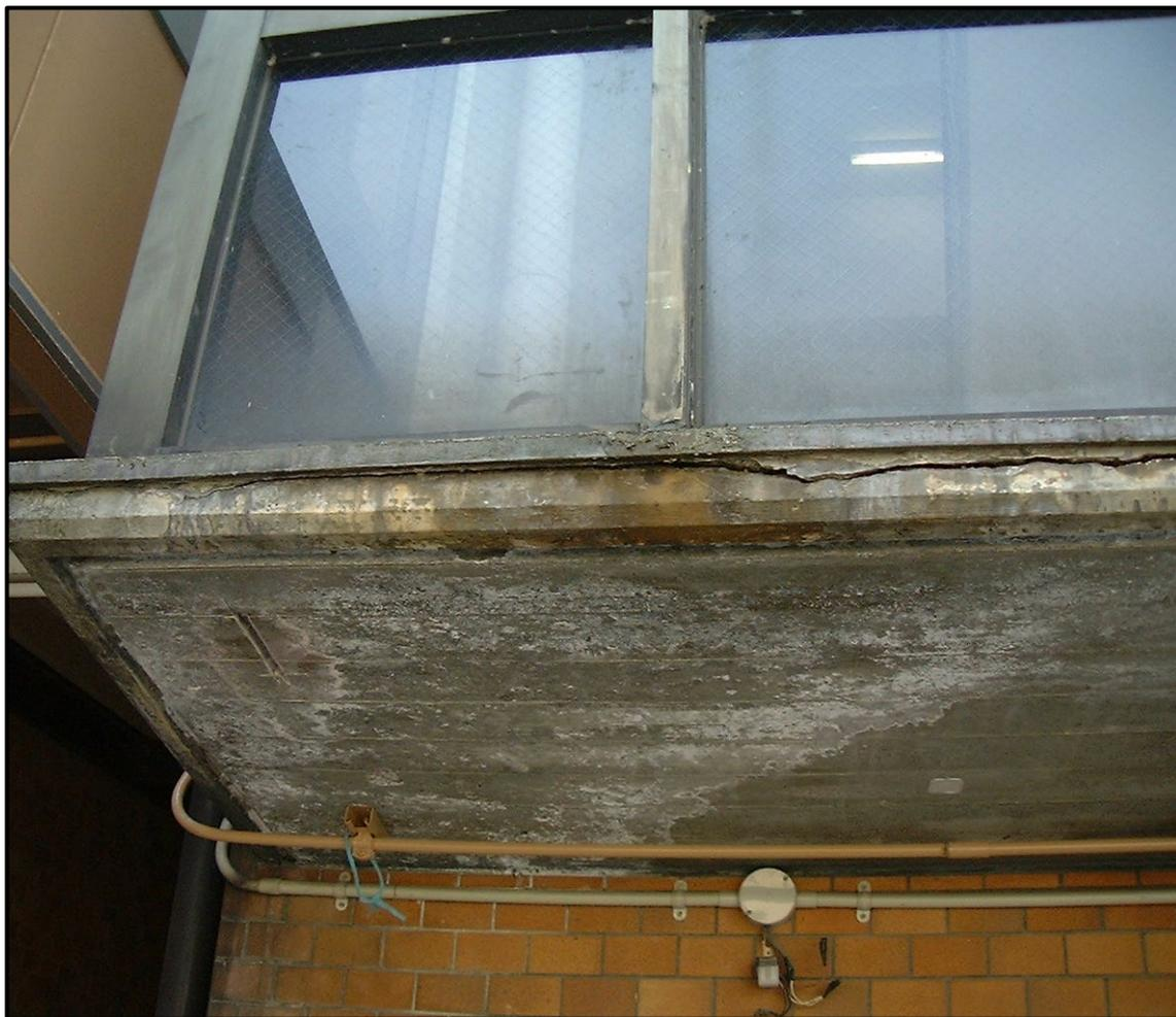
窓下の漏水劣化
