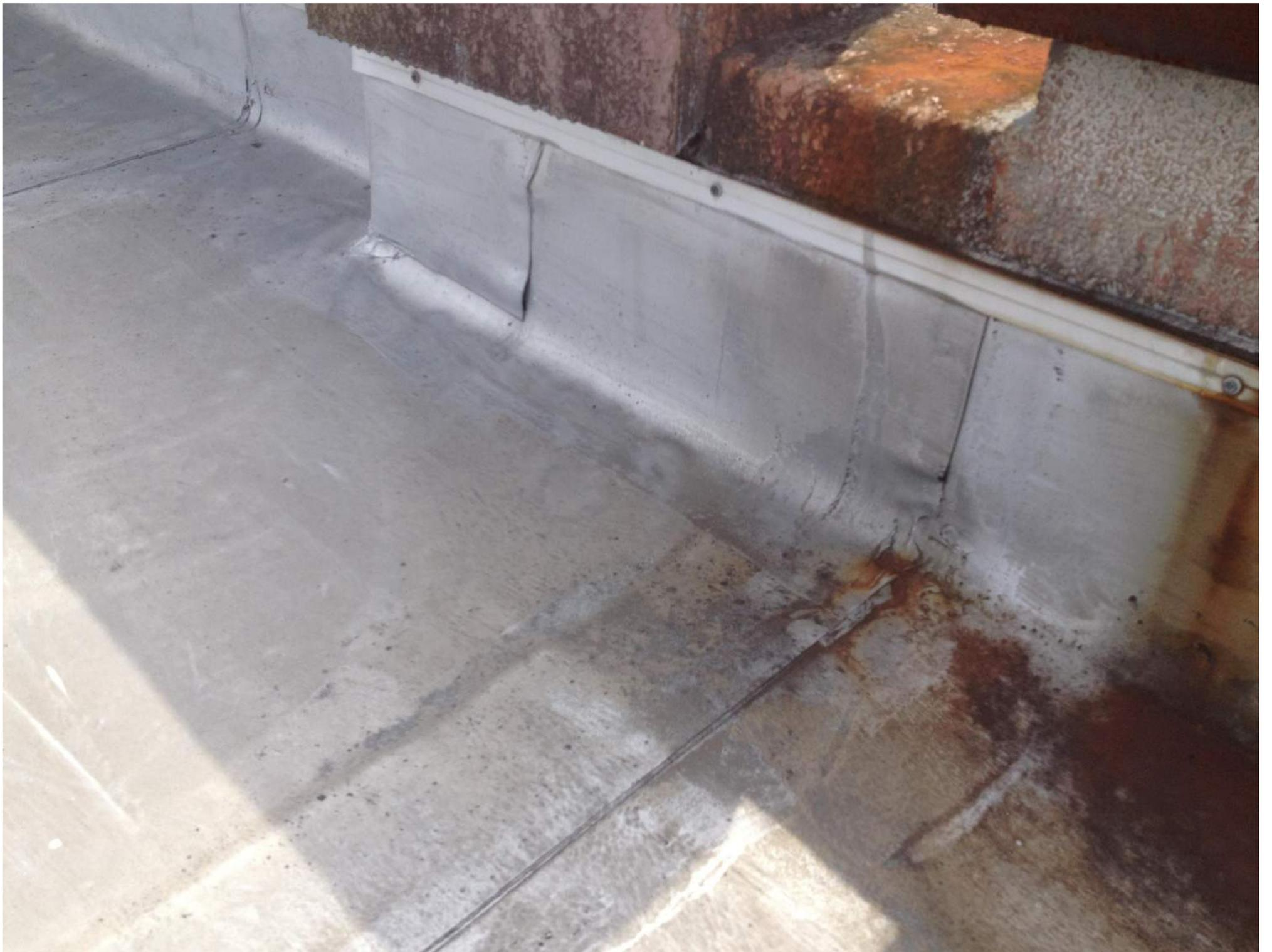
コーキングの箇所や、シート防水のジョイント部分、防水の立上り部分、各部取り合い部分全てにファブリックメッシュで下地処理を施した後、ガーディアン（緑）を塗布する。
