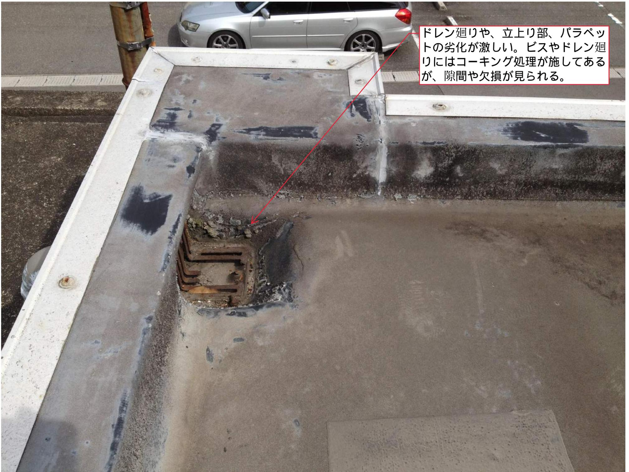
ドレン廻りや、立上り部、パラペットの劣化が激しい。ビスやドレン廻りにはコーキング処理が施してあるが、隙間や欠損が見られる。
