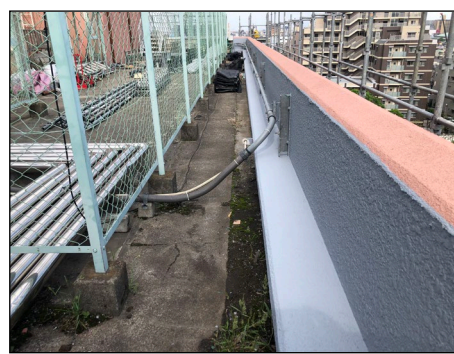
屋上外壁壁面
