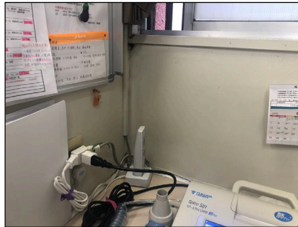
濡れていた壁表面が工事後乾燥してます。
