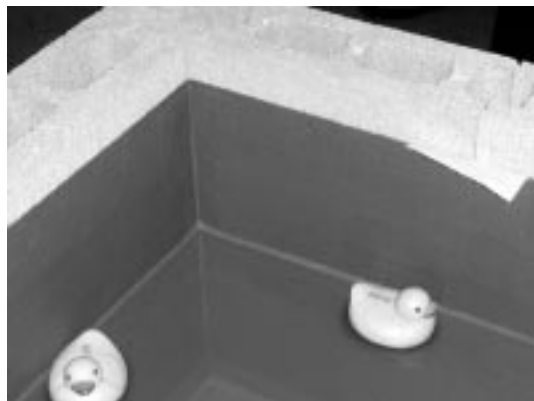
写真8 水槽内側に塗られたガーディアン
