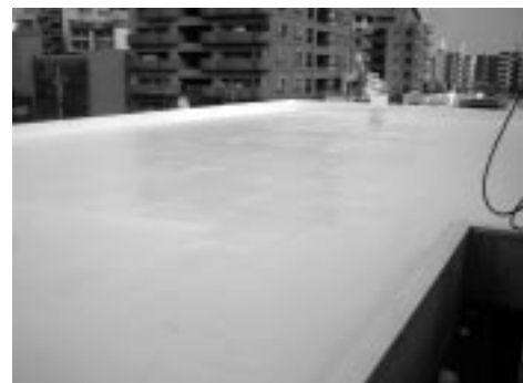
写真29 完成したエコルーフシステム
