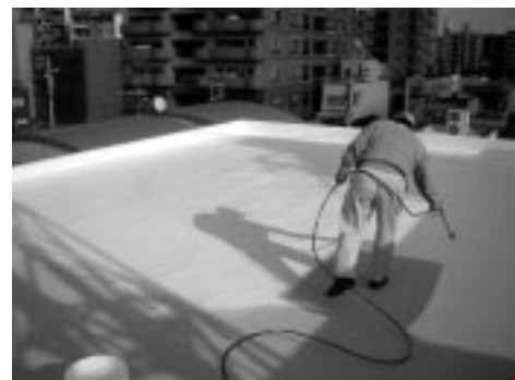
写真28 スプレーガンによる仕上げ材の塗布
