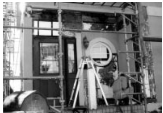
写真3 腐食した玄関周り
