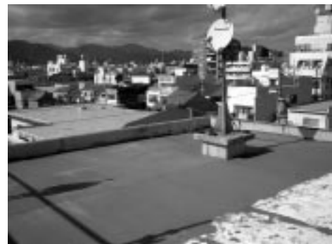
写真27 断熱材の上に施工したファブリックと下地材
