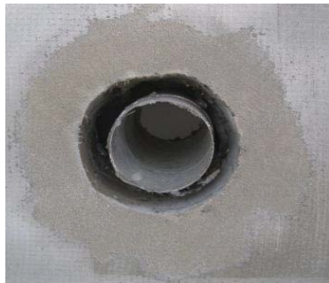
パイプ収まり
