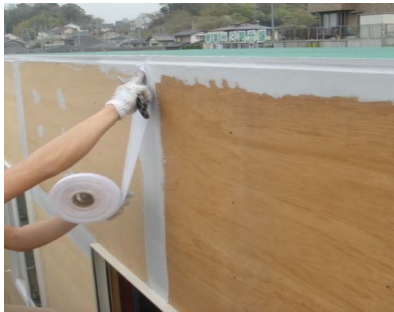
下地材のジョイント部
