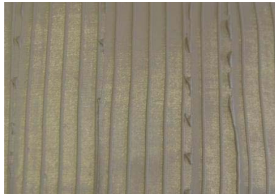
EPS接着面の樹脂モルタルは 水が流れるように縦に塗る
