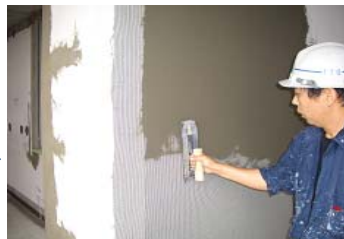
②樹脂モルタルにメッシュを埋め込む
