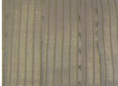
EPS接着面の樹脂モルタルは 専用接着鍍で縦に塗る
