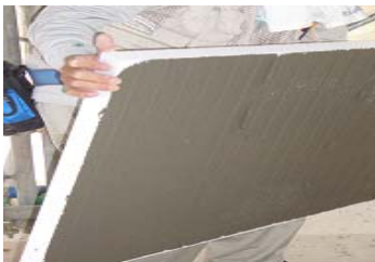
EPSに樹脂モルタルを縦法行為に塗る
